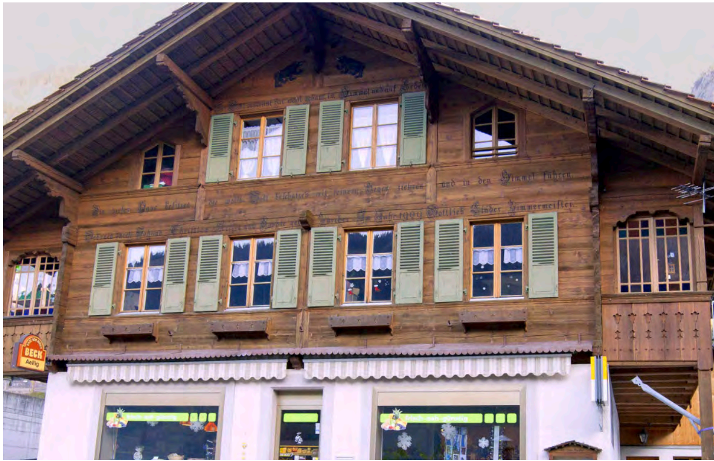
Der Tatort: In der Wohnung über der Bäckerei in Kiental wohnte das Opfer – an der Fassade prangt die Inschrift: «Die dieses Haus besitzen, die wolle Gott beschützen mit seinem Segen zieren und in den Himmel führen.»
