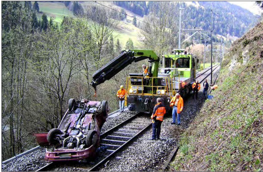
So endete die Irrfahrt des Geisterautos: Das abgestürzte Auto wird von Bahnarbeitern mit dem Bergungszug von den Gleisen der Bahnlinie Spiez–Zweisimmen (Bild Fahrtrichtung Zweisimmen) gehoben. zvg
