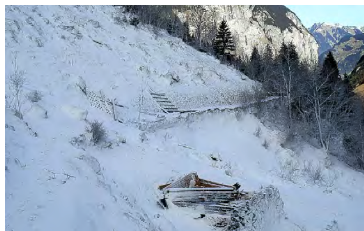
Unter dem Busen zerstörte die Eislawine diese Scheune «ufem Biel», die Dachhälften liegen oberhalb vom Wanderweg am Hang. Lesebild Matthias Feuz
